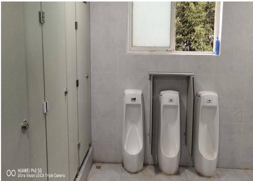
图 4-4 改造完成的卫生间
