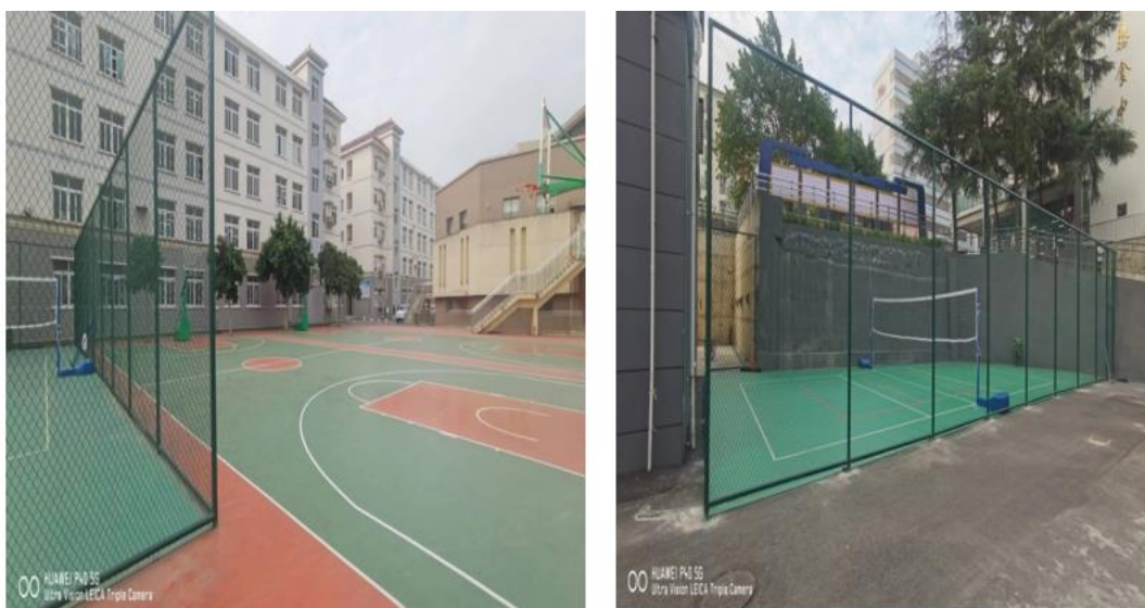
图 4-2 改造完成的学校篮球场、排球场
